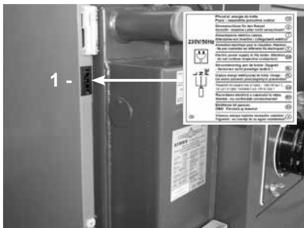
Conectori în partea dreaptă a cazanului
